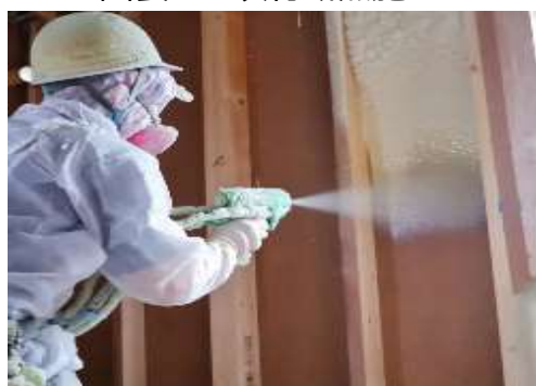
図表 3：吹付断熱施工
