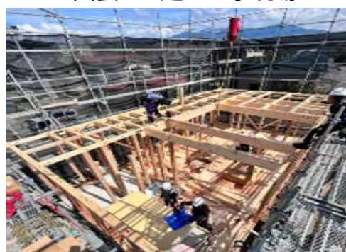
図表 4：建方工事現場
